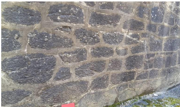
Imagen-27: Detalle de un sector del muro del azud en su paramento vertical aguas arriba
