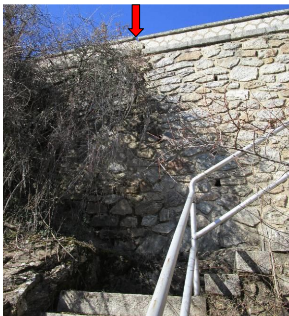
Imagen-8: Muro de contención donde se muestra la grieta vertical definida.
