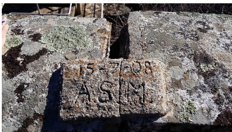
Imagen-10: Detalle de la cabeza del muro donde se aprecia la apertura de la grieta y el testigo de mortero colocado en fecha 15-07-2008.
