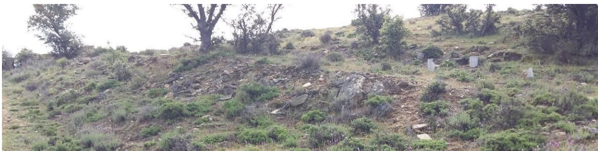
Imagen-17: Rellenos localizados a modo de cordón a lo largo de la conducción existente.
