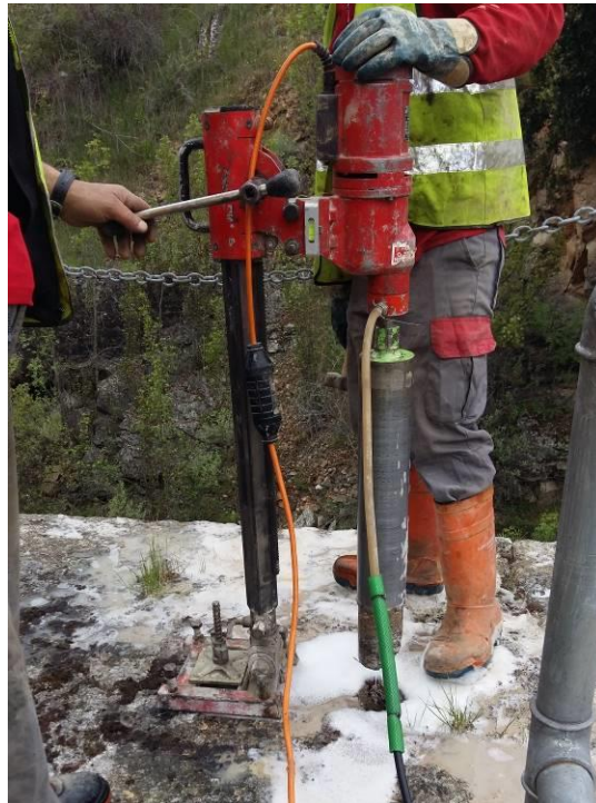
EMPLAZAMIENTO PERFORADORA HILTI
