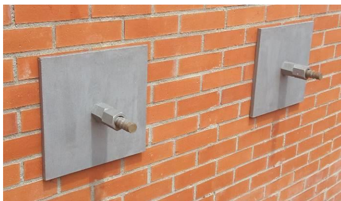
Imagen-36: Bulones pasivos con placa y doble rosca.
