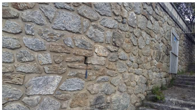
Imagen-33: Paramento exterior del muro de contención de la plataforma de acceso al azud del Tenebroso.
