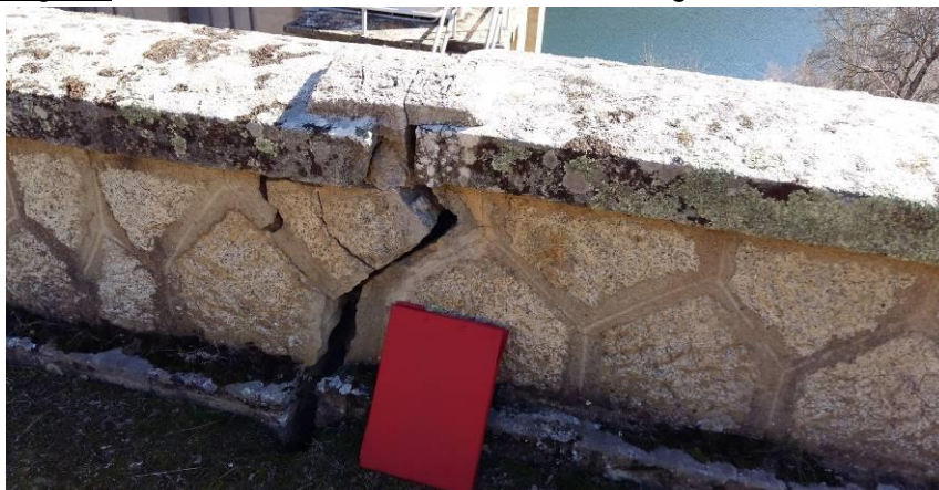
Imagen-9: Cabeza del muro donde se aprecia la grieta principal que progresa en el terreno trasdosado.
