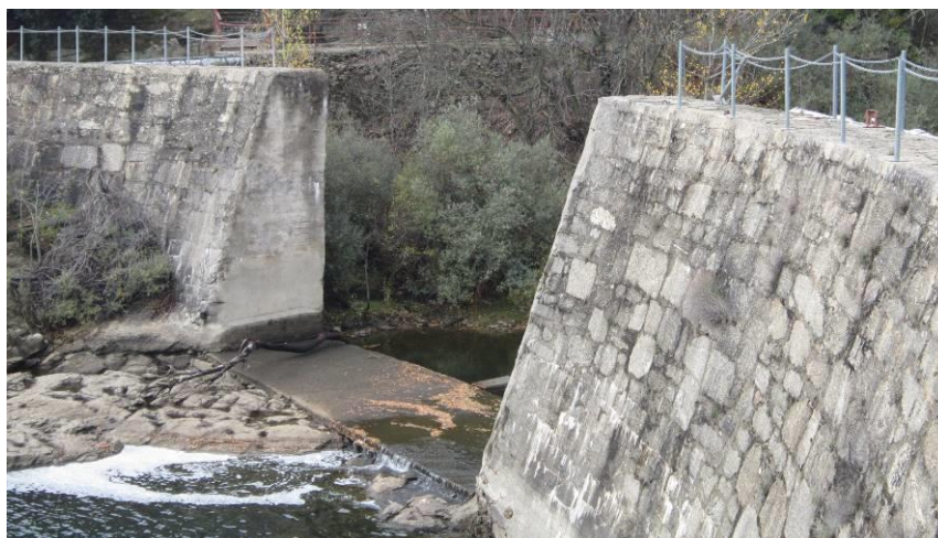
Imagen-29: Escotadura en el azud del Tenebroso
