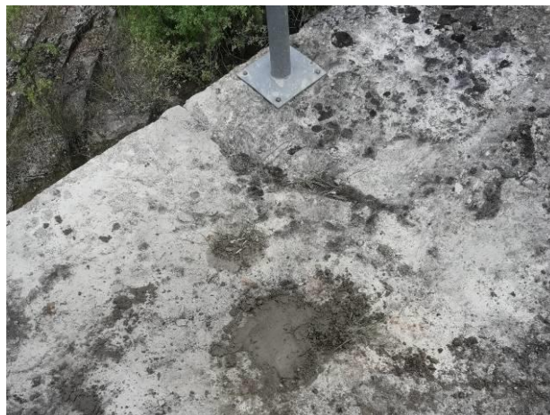
SELLADO DE PERFORACIÓN CON MORTERO
